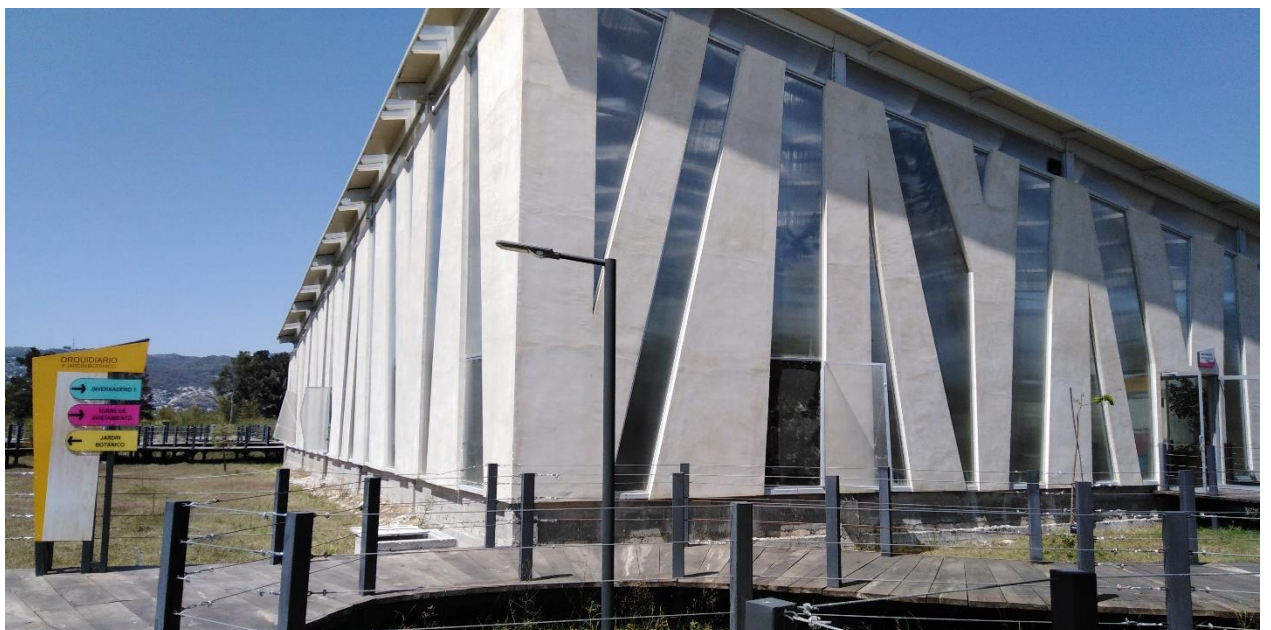
Fotografía 4. Edificio principal del orquidario
